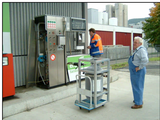
Eichung einer Zapfsäule für Busse
