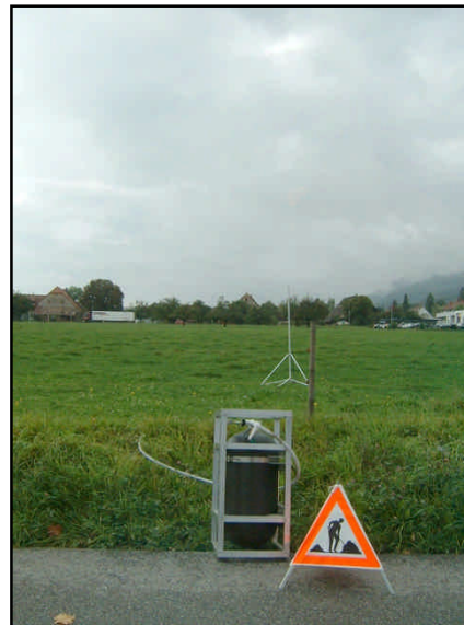
Gasabfackeln, wenn Korrekturarbeiten nötig sind
