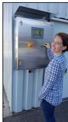
autom. Betankung mit Badge-Erkennung nicht temperatur- kompensiert
