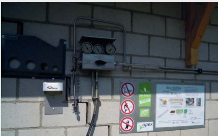
Fig. 6 Manuelle 2-Bank-Konsole für die Fahrzeugbetankung Console manuelle de 2-banques de stockage
