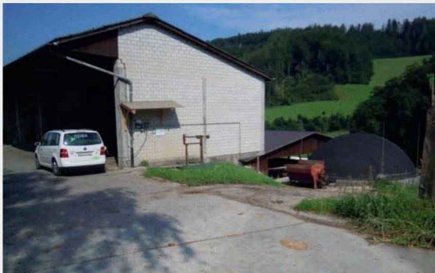
Fig. 4 Biogaszapfstelle mit Fermenter im Hintergrund Pompe avec digesteur en arrière-plan
