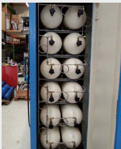
Fig. 8 Der Hochdruckspeicher besteht aus 12 75-Liter-Einzelflaschen L'accumulateur à haute pression comprend 12 bouteilles de 75 litres
