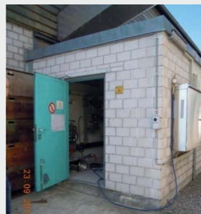
Fig. 10 Einspeisestation der Energie 360° AG (Schlauch für Gasanalyse während der Inbetriebnahme) Station d'injection d'Energie 360° AG (tuyau pour l'analyse du gaz durant la mise en service)
